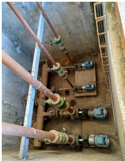
Figura 12. Bombeo de fangos
