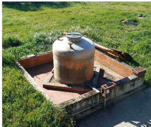
Figura 10. Cuba de almacenamiento de floculante. Sin uso
