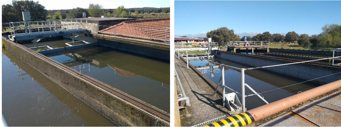
Figura 11. Sistema de recogida de flotantes de barredera superficial
