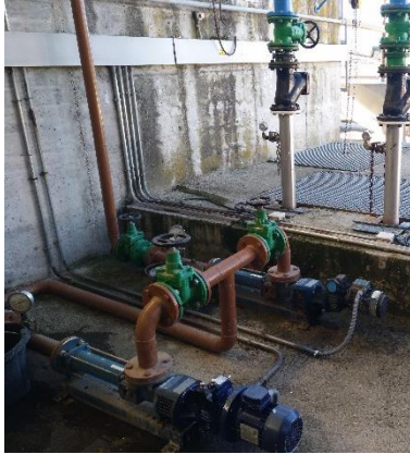
Figura 13. Bombas de aspiración de fangos
