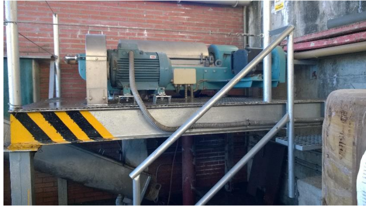
Figura 15. Centrifugadora de secado de lodos
