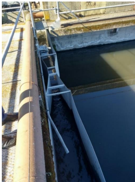
Figura 7. Medida de caudal
