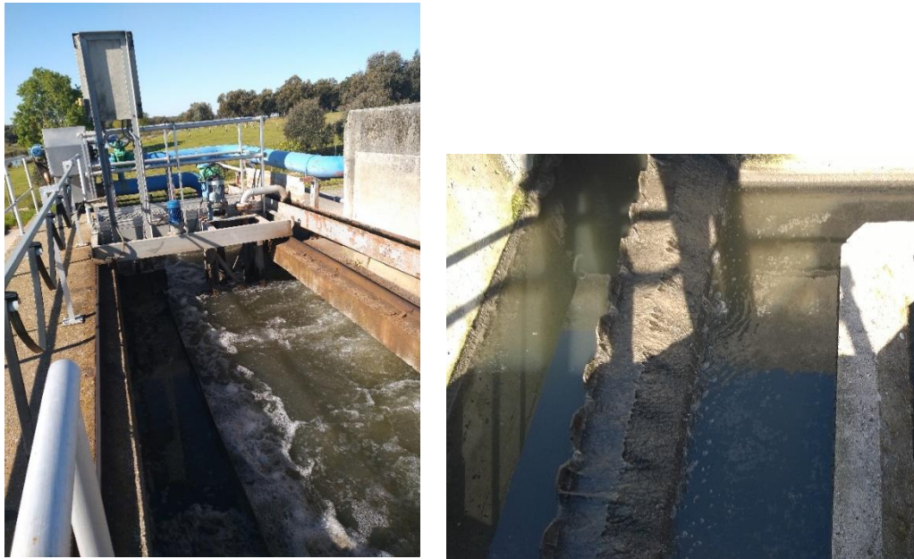
Figura 5. Desarenador-desengrasador
