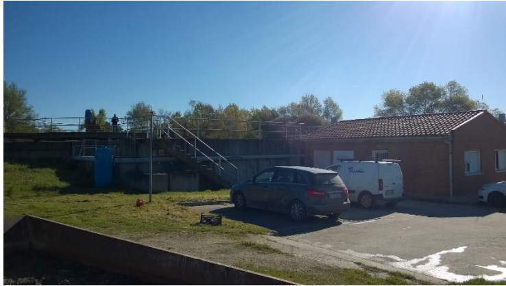
Figura 18. Urbanización y cerramiento
