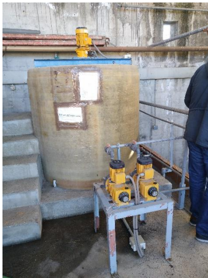
Figura 14. Depósito de almacenamiento de polielectrolito
