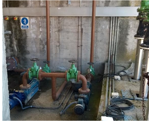
Figura 13. Bombas de aspiración de fangos
